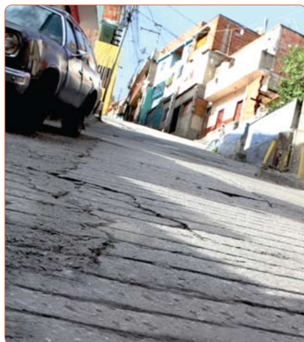
Mil 400 metros de tubería sube callejones y calles de San José de Carapita
