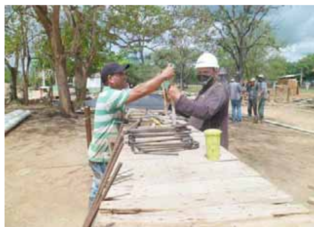
Cuadrillas de obreros arman las estructuras
