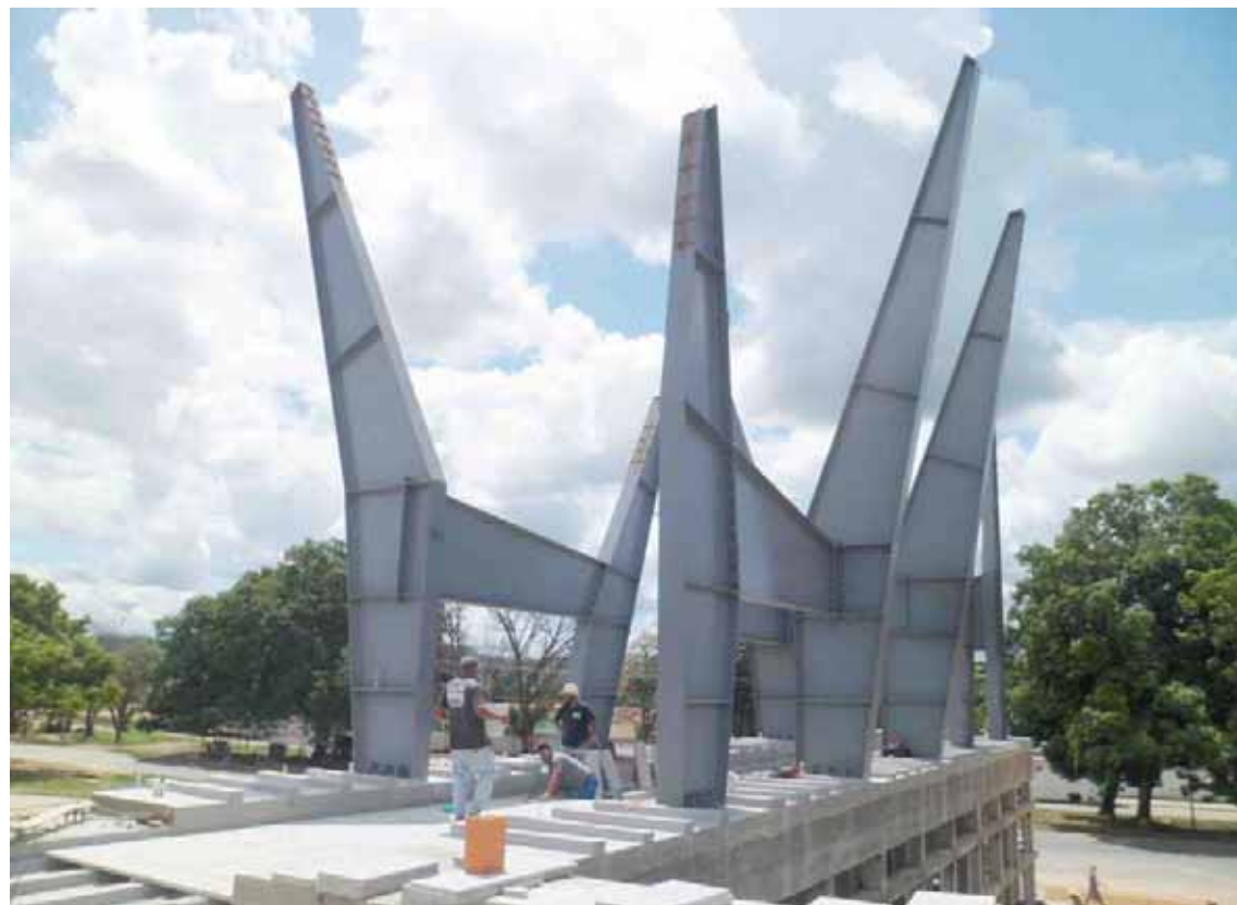
Las obras se ejecutan a toda marcha
