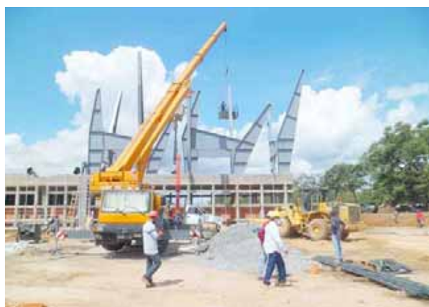
Para fines de mayo se espera que concluyan los trabajos
