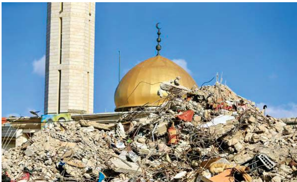
Un edificio dañado en Baraashit, en el distrito de Bint Jbeil, en el sur del Líbano, tras un ataque aéreo israelí
